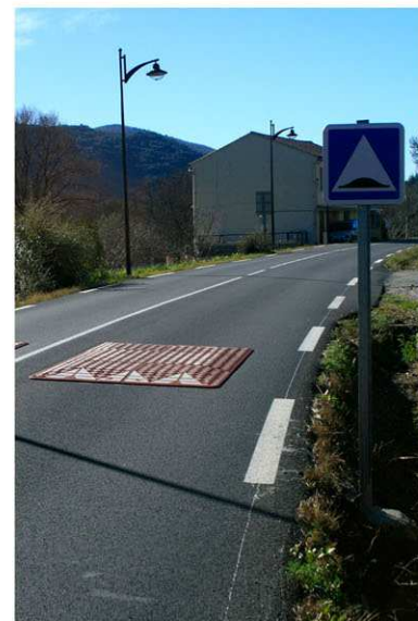
Radar pédagogique et coussin berlinois au Tour des Ponts à l'entrée Ouest du village.
